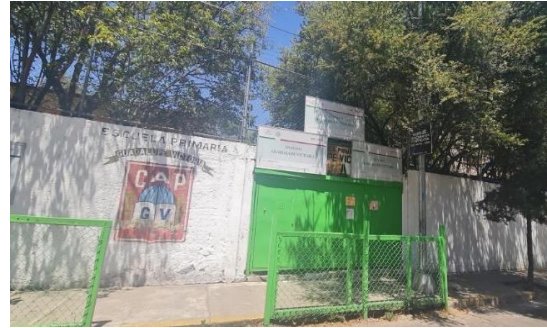
Fotografía No.14. Primaria Guadalupe Victoria.
