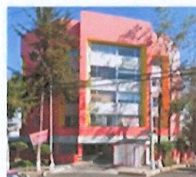
Calzada de los Corceles 300 5 niveles
