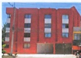
Calzada de los Corceles 1074 4 niveles
