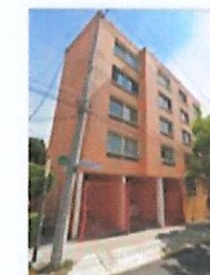
Calzada de los Corceles 245 5 niveles
