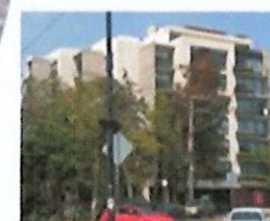
Calzada de los Corceles 13 6 niveles
