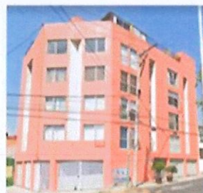
Calzada de los Corceles 284 4 niveles
