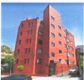
Calzada de los Corceles 1078 5 niveles
