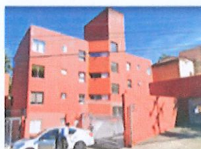
Calz. de las Arcadas 97 4 niveles
