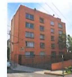
Calzada de los Corceles 245 5 niveles
