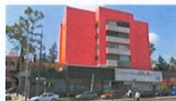
Calzada de los Corceles 1120 5 niveles
