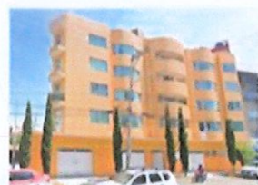
Calzada de los Corceles 1060 4 niveles
