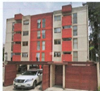
Calz. de las Carretas 112 4 niveles
