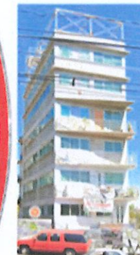
Av. Centenario 1080 6 niveles
