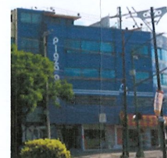
Av. Centenario 1100 4 niveles
