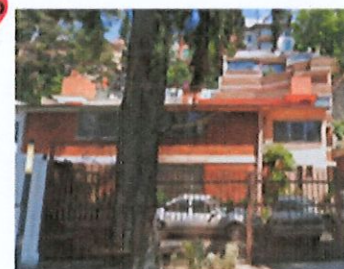
Calz. de las Carretas 63 4 niveles
