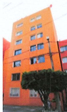
Rinconada Centenario 36 7 niveles
