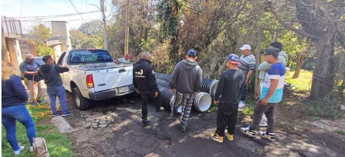
Rehabilitación de drenaje calle Buenavista en beneficio de 500 familias, Santa Rosa Xochiac.
