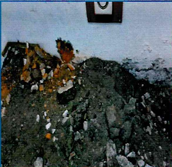
**BAÑO 1: SE RETIRARON MUEBLES , SE RELLENO EL PISO CON TIERRA PARA QUE QUEDARA A NIVEL DE PISO Y SE INSTALARÁN MUEBLES NUEVOS.**
