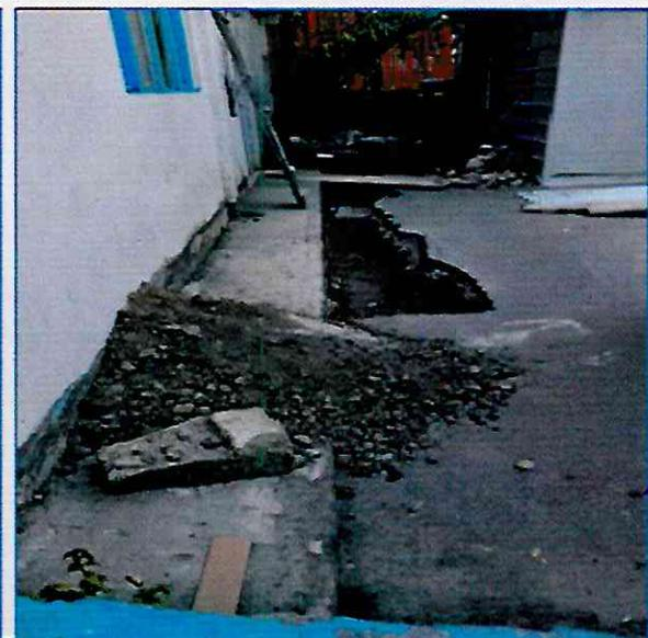
REGISTROS DAÑADOS Y ABERTURA DE SANJA PARA LA CONSTRUCCIÓN DE UN NUEVO REGISTRO PARA DESAGUE Y COLOCACIÓN DE TUBO DE PVC PARA SUSTITUIR EL TUBO DE ALBAÑAL QUE COLAPSO.
