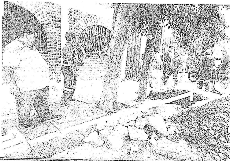
El tubo para la reparación de la fuga abarca desde donde se realizó la abertura hasta donde el arquitecto sostiene la marca
