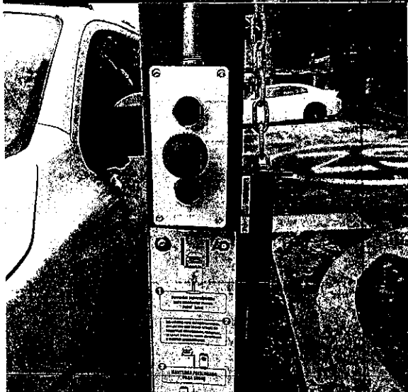
RAMPA 285/ 286 CAMBIO DE CONTACTOR
