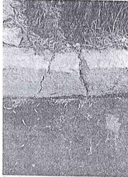
Árbol 1 para poda requiere ampliación de cajete y reparación de banqueteta
