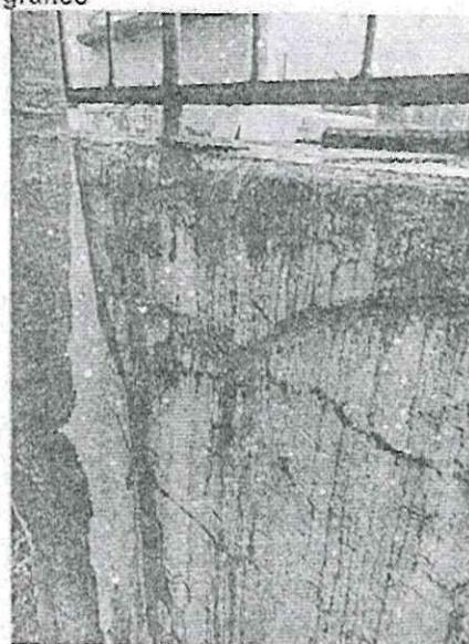
Árbol 3 para derribo provocó humedad en barda perimetral y daños estructurales
