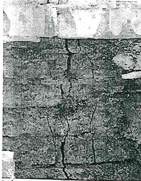
**Se observa sistema radical afectado este muro y contramuro**
