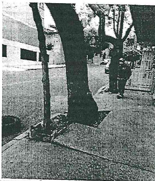
Arbol 1 que ocasiono fisuras en el concreto
