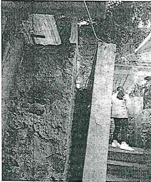
Sistema radicular ha inclinado murete y jardinera
