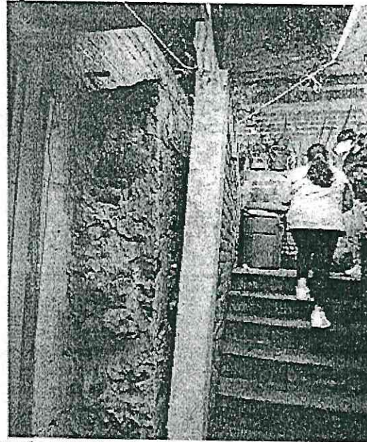
Sistema radicular ha inclinado murete y jardinera
