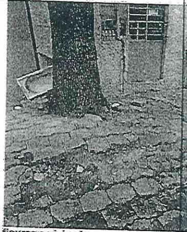
Afectación a adoquín y fisuras a vivienda
